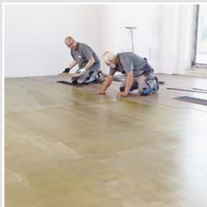
Dankzij de lange inlegtijd is het mogelijk om grote vlakken achter elkaar te leggen.
